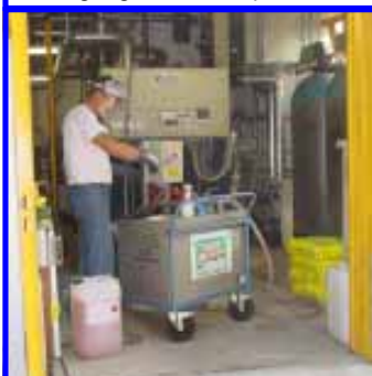
EWKS-Service bei der CIP-Reinigung eines Dampfkessels
