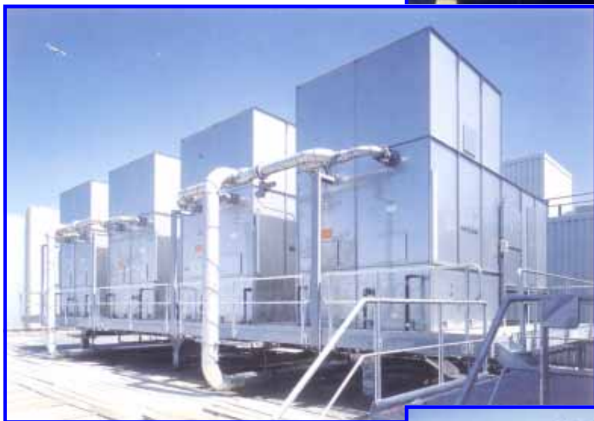
9 Kühltürme K-Baureihe mit gesamt 5.600 kW Kühlleistung Prozesswasserkühlung
