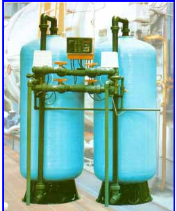
Enthärtungsanlagen von EWKS in zuverlässiger und robuster Industriequalität gewährleisten die erforderliche Wasserqualität mit konstruktiv bedingter hoher Lebensdauer
